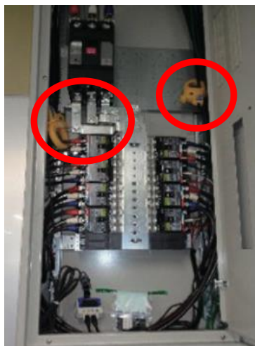
計測器設置状況
