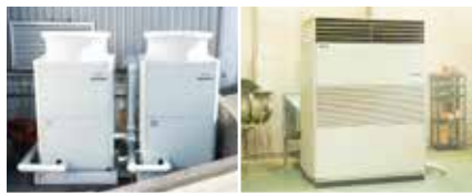
高効率空調機へ更新
