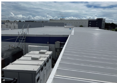
遮熱塗装を施した屋根
