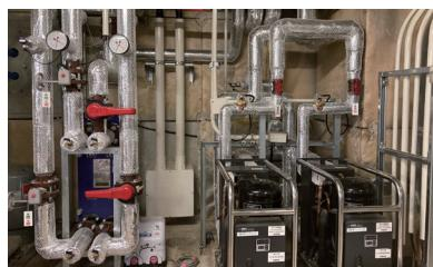
温泉排湯から廃熱を熱回収するヒートポンプ(右)と、融雪用プレート式熱交換器(左)。冬季のロードヒーティングにも温泉の廃熱を活用している。
