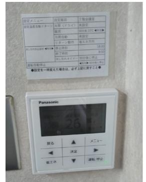
空調の操作盤のすぐ上に、設定を一時的に変更した場合に元に戻すための“設定メニュー”を表示し、注意喚起。
