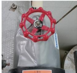
保温施工を実施した配管とバルブ部分の拡大写真
